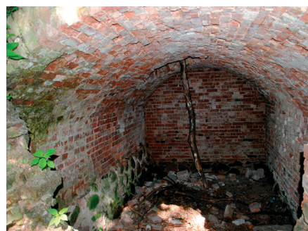
Piwnica magazynu przy młynie
